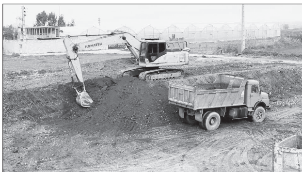
درصنعت کشتارگاه می‌باشد. مهدی دیگ پخت ۷ هزار لیتری و سیستم تکمیلی حذف بو، ۵۰۰ متر خط انتقال سیروس راد افزود: این پروژه شامل خرید
